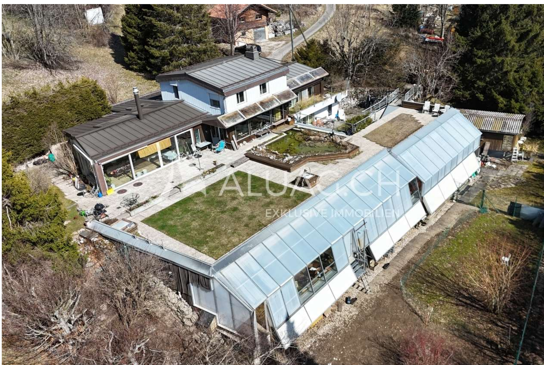
1984 Anbau vom riesigen Untergeschoss. Dadurch ist auch die tolle Sonnenterrasse mit Biotop entstanden.
